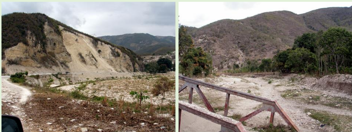
Sapement et élargissement excessif de berges de rivières et effondrement de ponts
